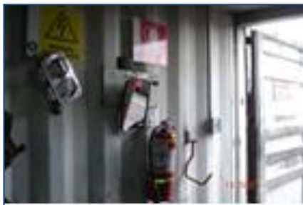
FOTO 26: Mantenimiento – Río Coca
